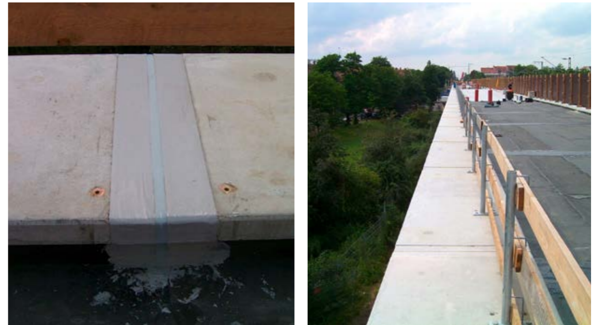
Ablebung von Raumfugen zwischen Betonfertigteil Randkappen mit Sikadur-Combiflex® TF Dichtstreifen
